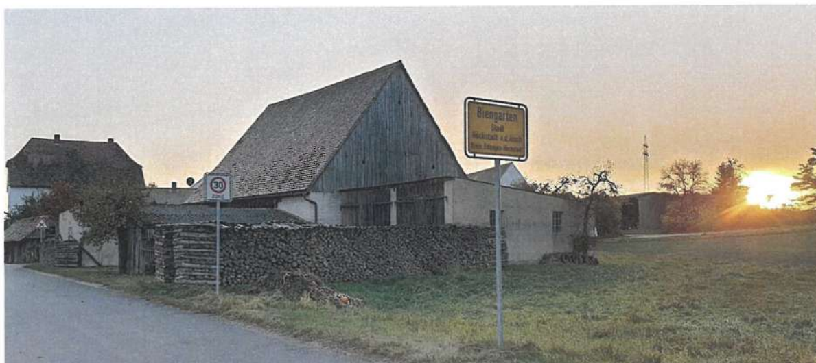
Bestehende, bisher landwirtschaftlich genutzte Halle, die zu einer Tierarztpraxis (EG) mit Wohnung (OG) umgebaut werden soll [VMB AG; 02.11.21]
