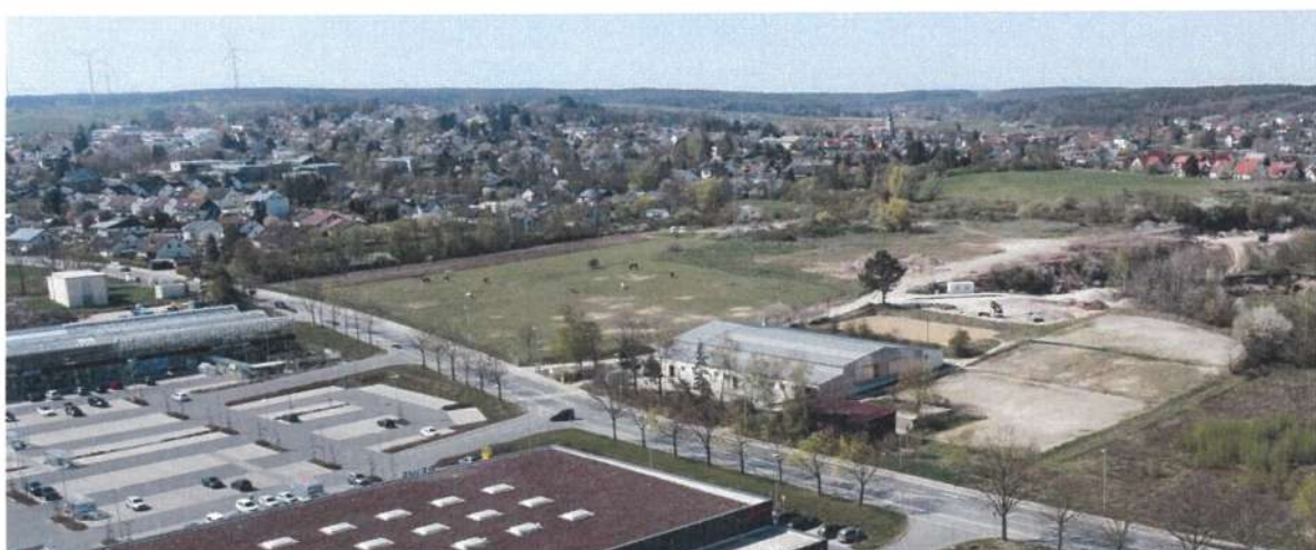
Drohnenaufnahme aus südlicher Richtung (vor Baubeginn der „St. Nicolaihöfe“) [VMB AG, Stand April 2021]
